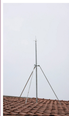
Instalação dos Sistemas de proteção contra descargas atmosféricas (SPDA) no Restaurante.
