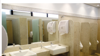
Reforma dos banheiros na entrada do Clube.
