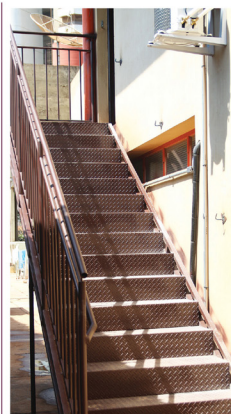
Troca da escada para camarim superior do palco externo.
