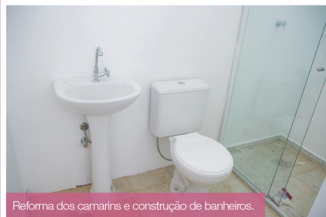
Reforma dos camarins e construção de banheiros.
