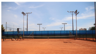
Instalação dos protetores contra luminosidade nas quadras 1, 2 e 3.
