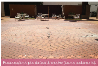
Recuperação do piso da área de snooker (fase de acabamento).
